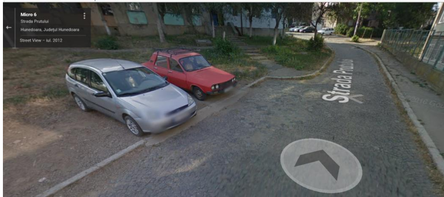
Figura 24 - Strada Prutului, Municipiul Hunedoara, sursa: https://www.google.ro/maps
